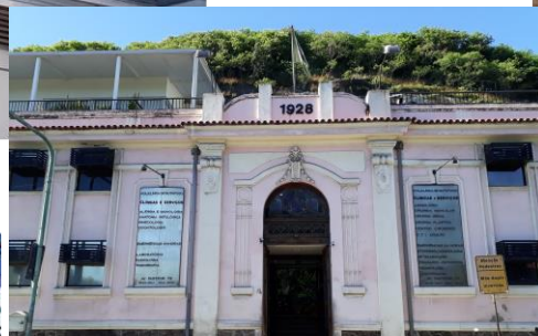
Policlínica de Botafogo
