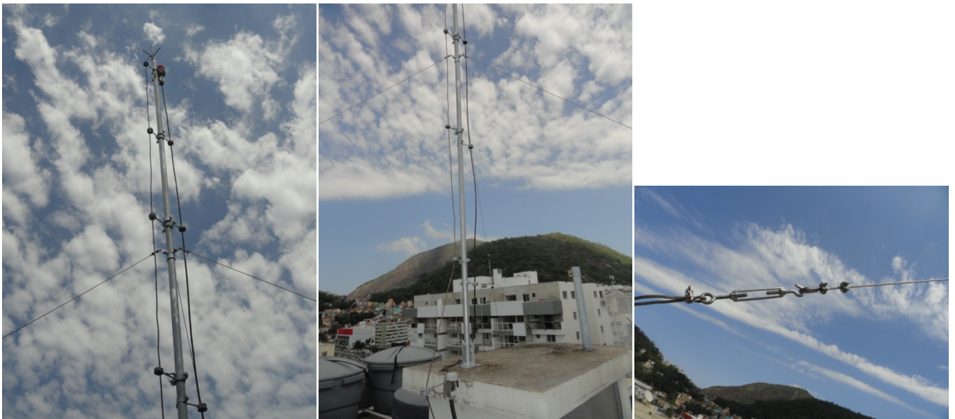
MASTRO PÁRA-RAIOS, APÓS PINTURA E SUBSTITUIÇÃO DAS FIXAÇÕES.
