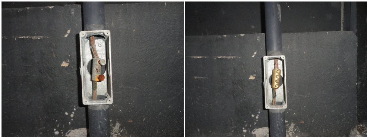
SUBSTITUIÇÃO DOS CONECTORES DE MEDIÇÃO.
