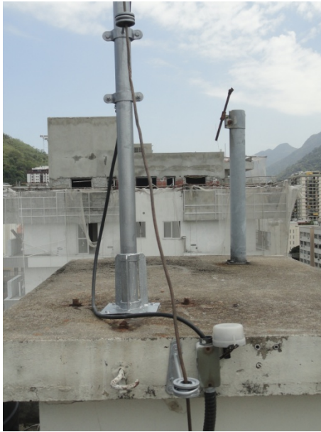
PINTURA E RECUPERAÇÃO DA BASE DO MASTRO DO PÁRA-RAIOS.
