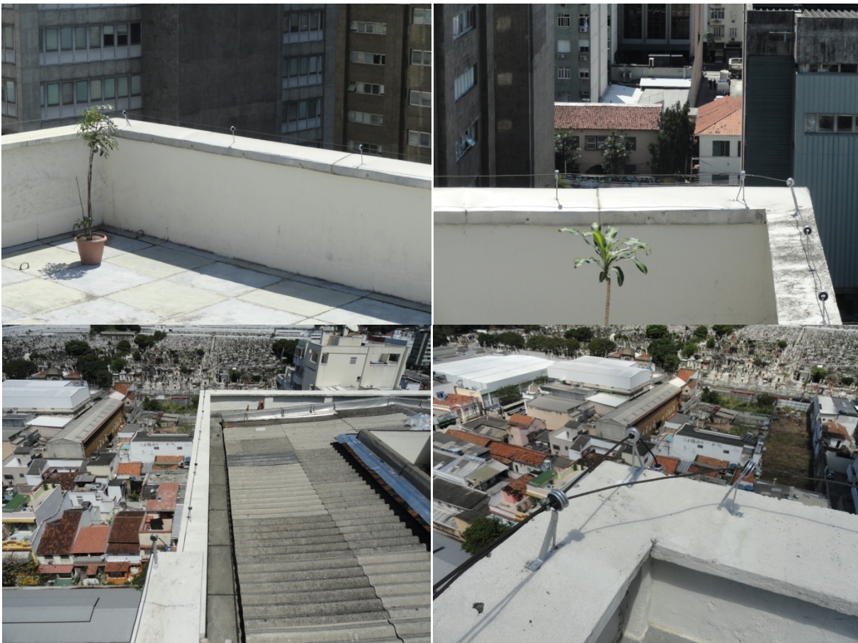
TENSIONAMENTO DOS CABOS DA MALHA CAPTORA COM INSTALAÇÃO DE ESTICADORES E NOVOS SUPORTES ISOLADORES .
